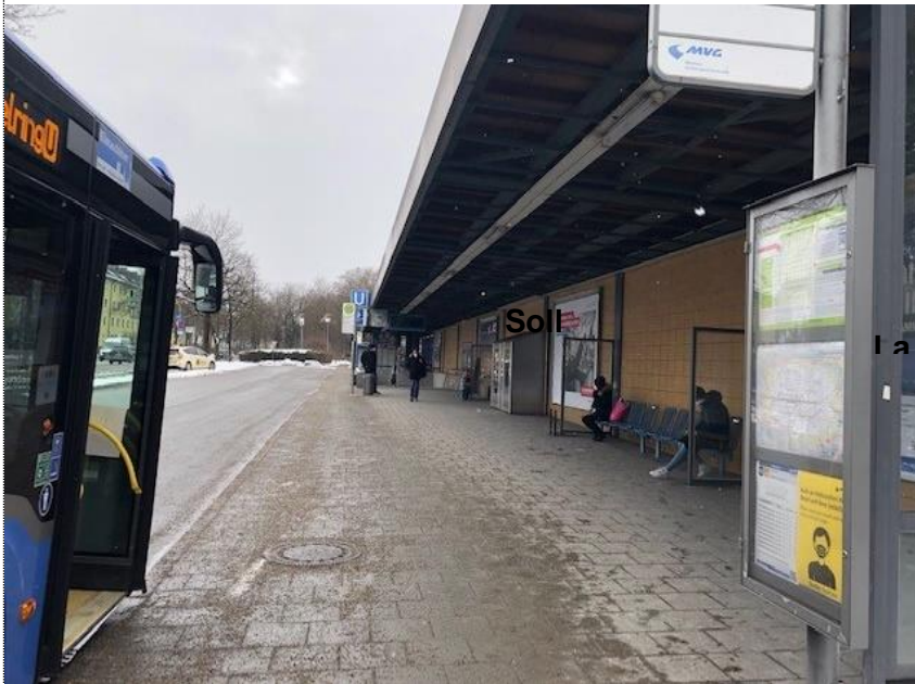
Abbildung 9: Busbahnhof Rückwand Bahnhofsgebäude
