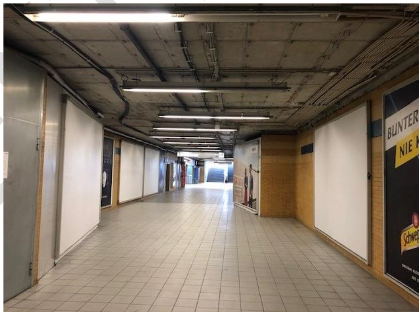
Abbildung 8: Sperrgeschoss – Demontage der Verkleidungen an Decken & Wänden
