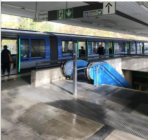
Abbildung 5: U-Bahnhof Studententadt – Bahnhofsüberdachung
