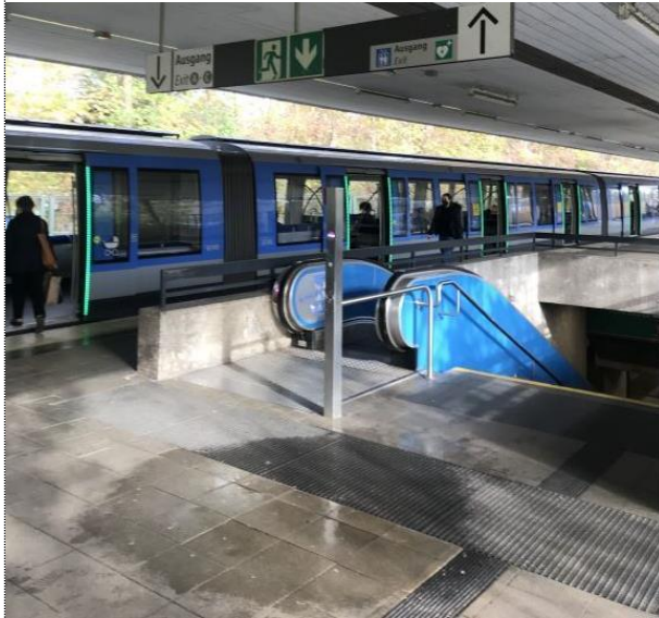
Abbildung 5: U-Bahnhof Studententadt – Bahnhofsüberdachung
