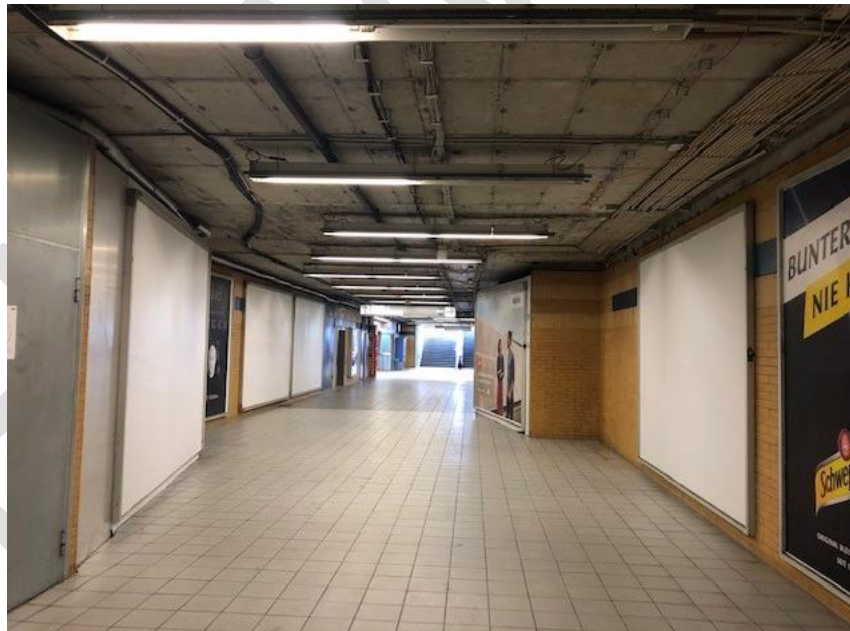
Abbildung 8: Sperrengeschoss – Demontage der Verkleidungen an Decken & Wänden
