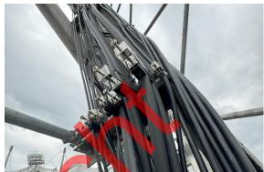
Die Leitungen zu den genannten Anlagen sind teilweise an, teilweise auf der Tragkonstruktion des Zeltdaches mit verschiedenen Befestigungssystemen befestigt.
