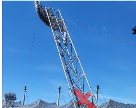
Die Leitungen zu den genannten Anlagen sind teilweise an, teilweise auf der Tragkonstruktion der Maste mit verschiedenen Befestigungssystemen befestigt.
