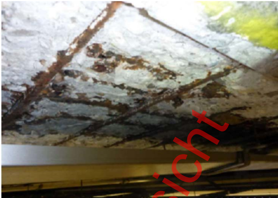
Abbildung 3: Betonabplatzungen
