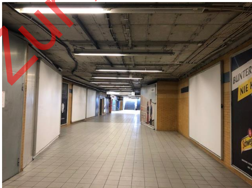
Abbildung 8: Sperrgeschoss – Demontage der Verkleidungen an Decken & Wänden
