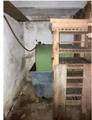
Öltank Keller Nebengebäude
