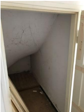
Abstellraum unter Treppe Wohnung EG
