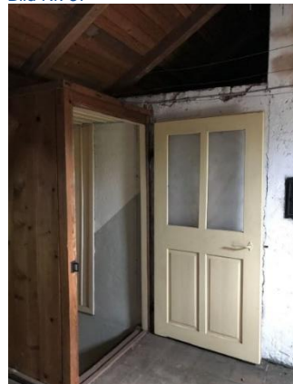
Treppenabgang DG (von Wohnung OG)
