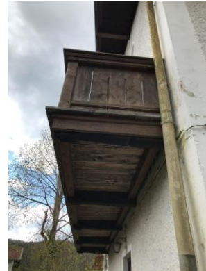
Außenansicht Balkon Wohnung OG – Betretungsverbot bei Besichtigung –
