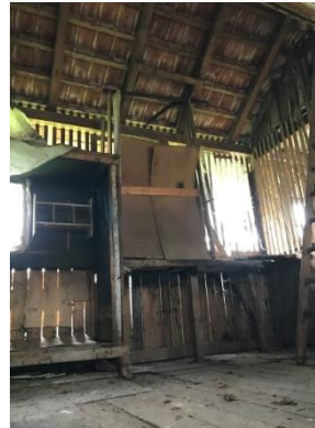
Innenansicht Nebengebäude (Holzteil)
